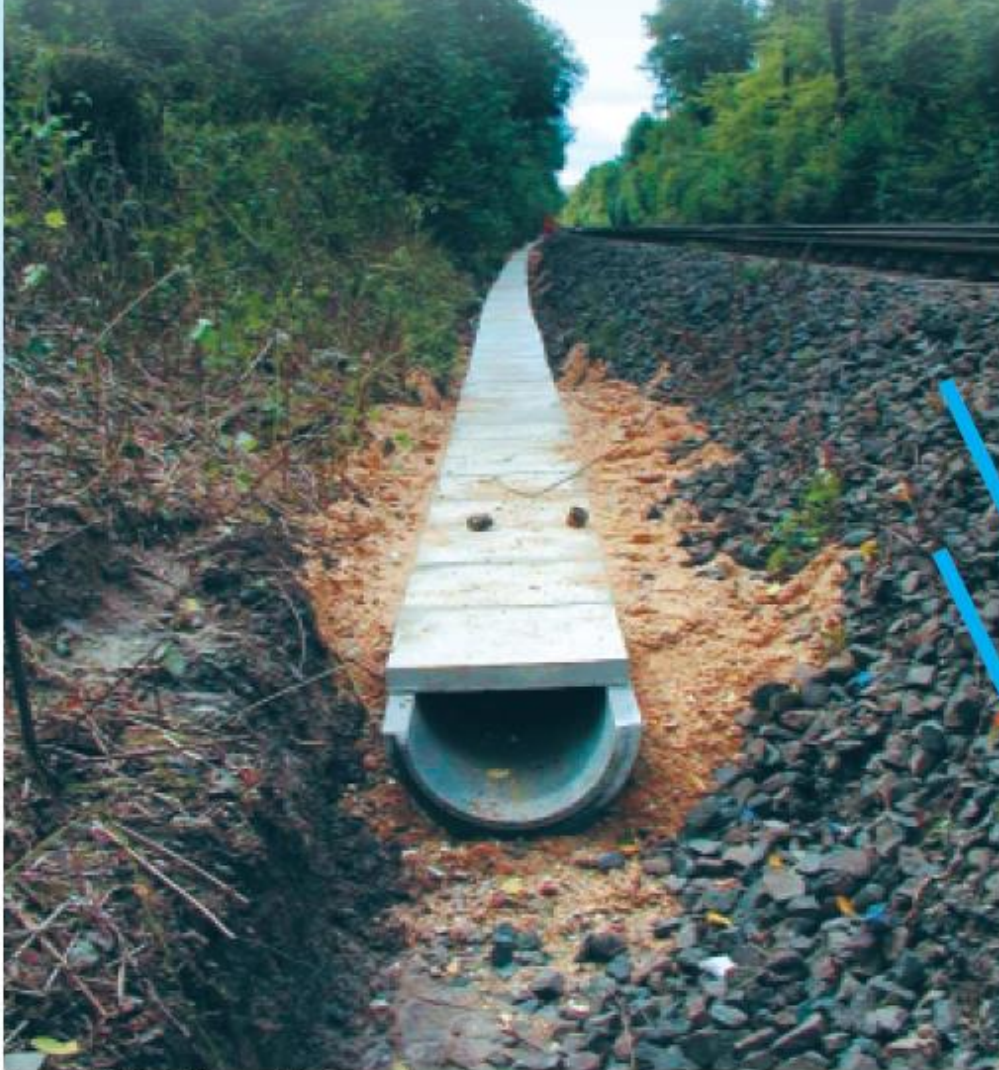
Porosit-Halbschalen im Einbaustadium
